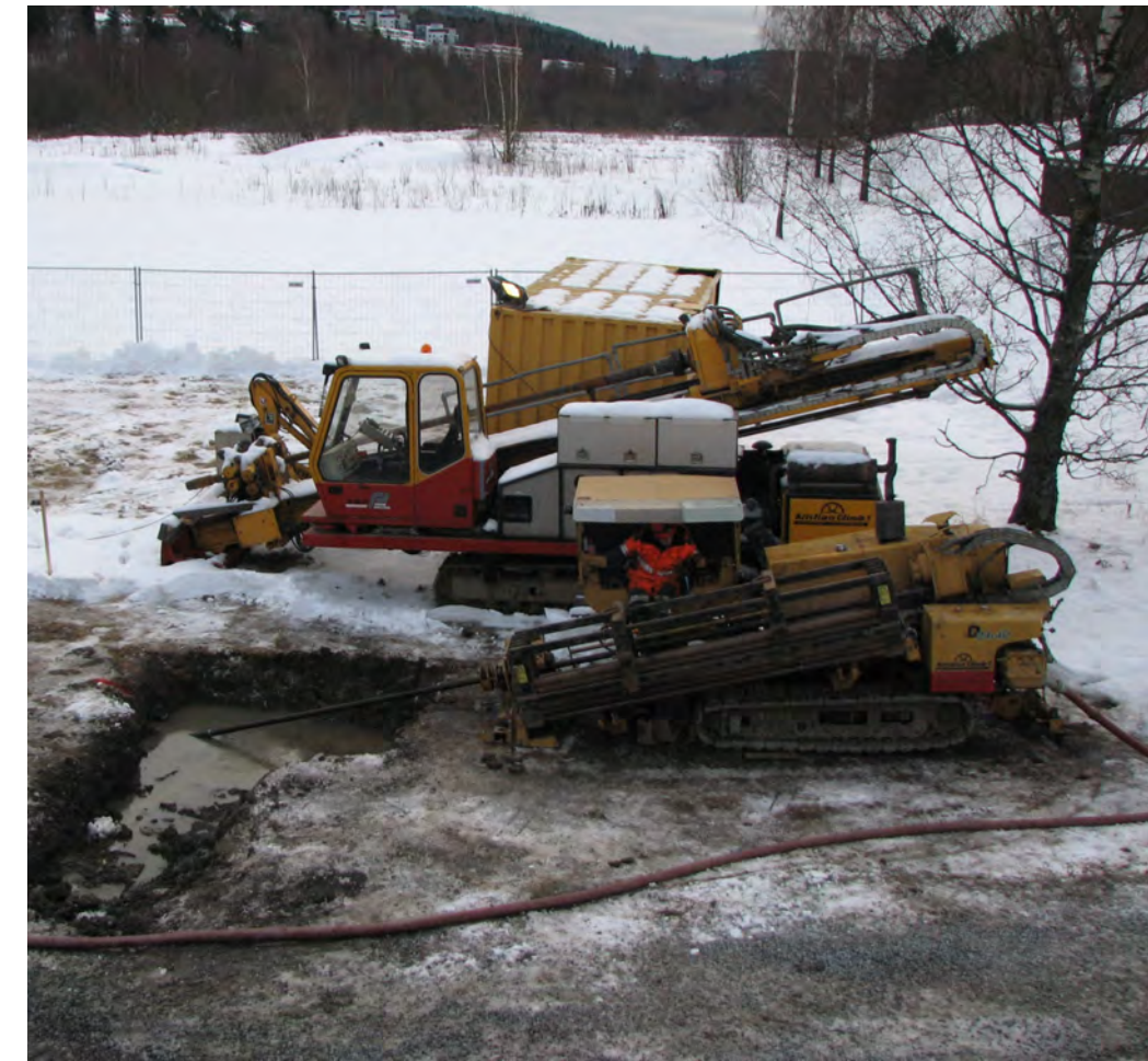
Med ny teknologi kan man med styrt boring trolig legge kablene i bakken med bruk av bare tre boregroper. Bildet viser maskinen som ble benyttet ved styrt boring da fjernvarmeledningen til Hafslund ble lagt under kanalen som forbereder Østensjøvannet med Bogerudmyra i januar 2009. Foto: Leif-Dan Birkemoe.
