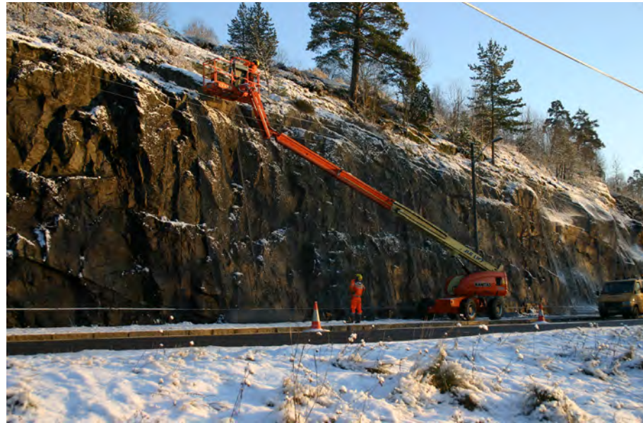
Stein- og issikring i fjellveggen på østsiden av Østensjøvannet i 2005.
