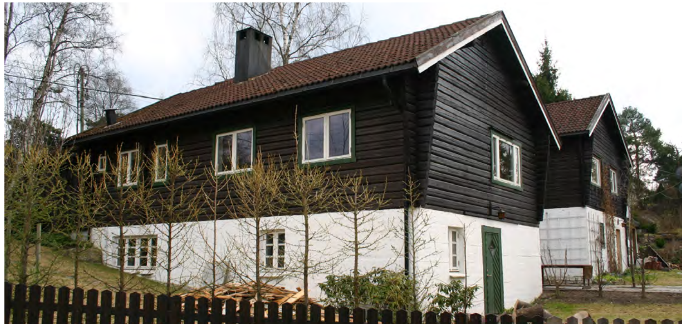
Haakon Tveters vei 29 står nå like støtt på høy grunnmur som den gjorde da den ble reist som offiserkasino i 1943. Den gjorde tjeneste både som officersmesse og velferdsbygg. Foto: Leif-Dan Birkemoe, 19.04.2004.
