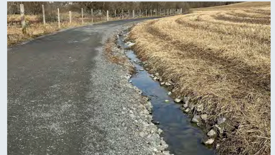
Langs kanten av jorden på Østensjø gård og turveien er det en dreneringsgrøft. Noen steder er det avrenning mot Bekkasinmyra som da blir kantsone mot Østensjøvannet. Foto: Leif-Dan Birkemoe, 22.03.2024.
