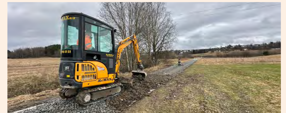
Over duken ble det lagt pukk som underlag før subus ga et fast og jevnt veidekke. Foto: Leif-Dan Birkemoe, 10.04.2024.
