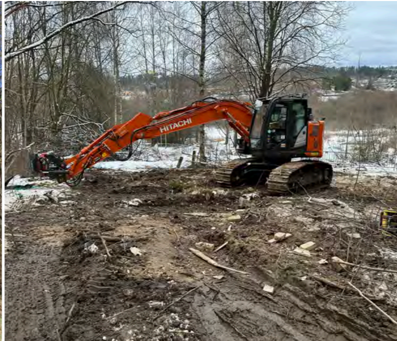
På ettermiddagen 19. mars hadde maskinen gjennomført rivningen. Alt var fjernet og fraktet vekk.
