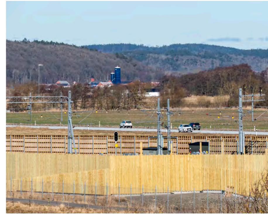
Ved Getterön naturreservat sør for Göteborg er toglinjen skjermet, og på strømlledningene henger mange fargerike, reflekterende ledningsmarkører som flagrer i vinden og er godt synlig for fuglene. Foto Håkan Billing.
